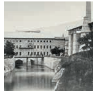
Zementwerk Heidelberg, 1873 erbaut
