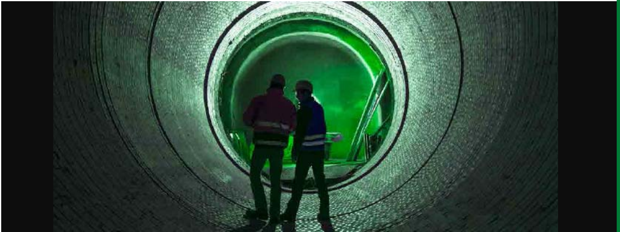
Blick in einen Drehrohrofen während der Winterreparatur
